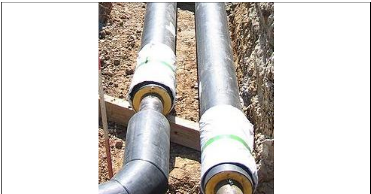
Abbildung 12: Zum Vergleich: Starres Kunststoffmantelrohr (Mediumrohr aus Stahl)
