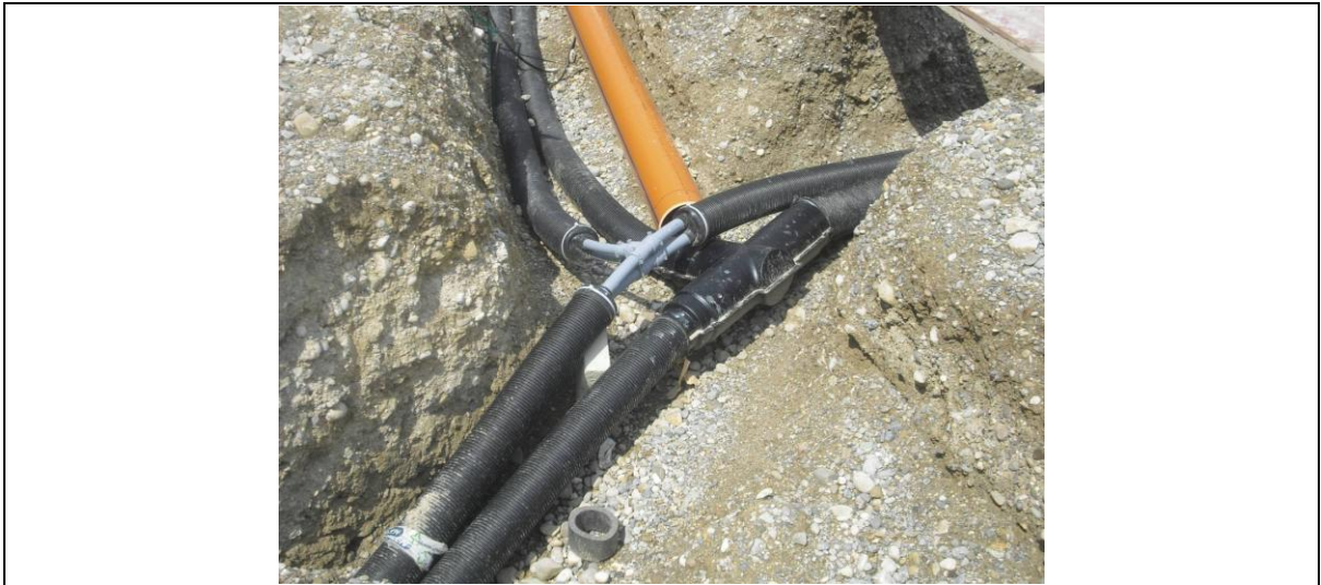
Abbildung 11: Flexible Kunststoff-Doppelrohre „von der Rolle“ (hier zwei Doppelrohre)
