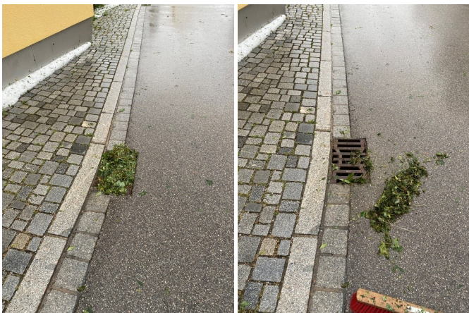
Fotohinweis: Bitte säubern Sie bei entsprechenden Wetterlagen umgehend die Zulaufsituation der Straßensinkkästen, welche in der Regel durch Hagel, Schlamm oder Laub den Abfluss verhindern.
